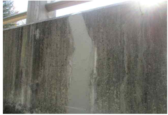
시점부 갯문 배면 재균열 보수
