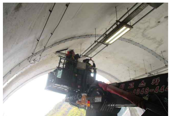
고소작업차를 이용한 외관조사 현황③
