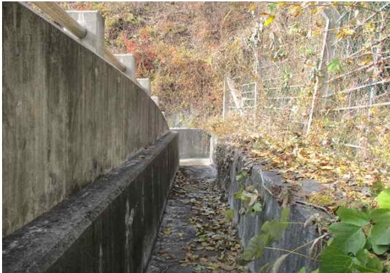
시점부 갯문 배면 상태양호
