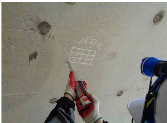
반발경도 측정 현황(천단부)
