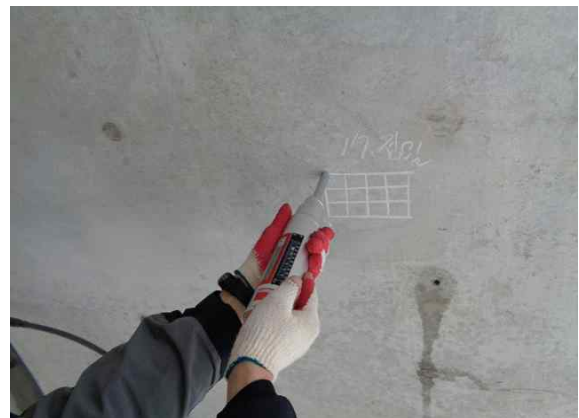
반발경도 측정 현황(측벽부)
