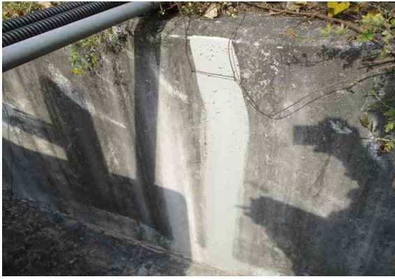
시점부 갯문 배면 균열 보수
