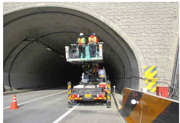
고소작업차를 이용한 외관조사 현황①
