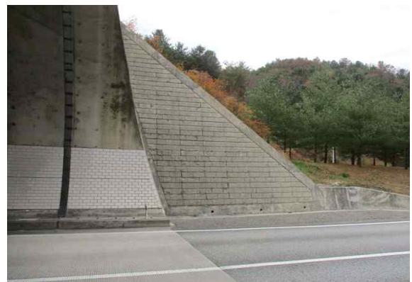
중점부 옹벽 전경
